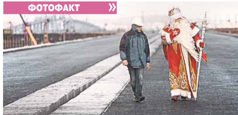
Первым пешеходом, перешедшим по Крымскому мосту с Таманского полуострова на берег Крыма, стал Дед Мороз. Новогодний волшебник часть пути прошёл по готовым пролётам, а остальную - по рабочим мосткам и технологическим площадкам, успев поздравить с Новым годом строителей и детей из Тамани и Керчи. Фото www.most.life.ru
